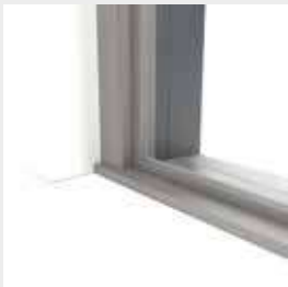
↑ Seuil plat, hauteur de 30 mm seulement.
